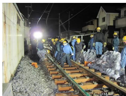
夜間工事の様子
