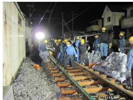
夜間工事の様子
