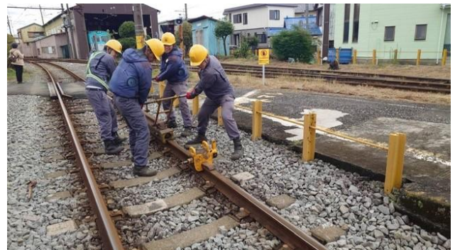
職場訓練(線路整備の機器取扱訓練)
