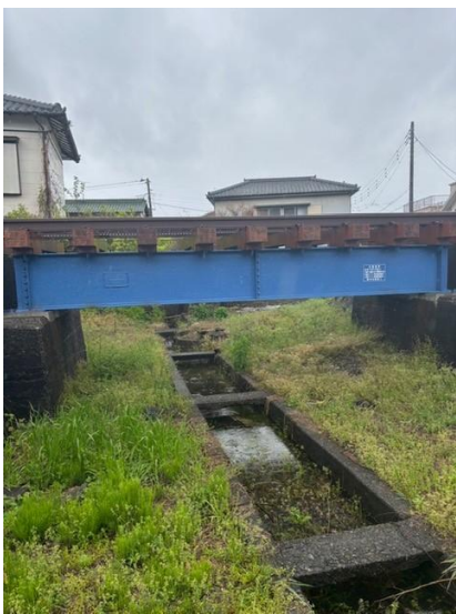
須津駅～岳南富士岡駅間 中里橋梁
