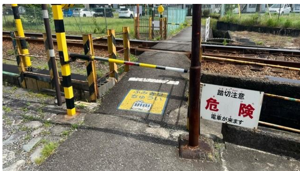
●興人南踏切(簡易遮断機)
