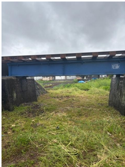
須津駅～岳南富士岡駅間 下河原橋梁
