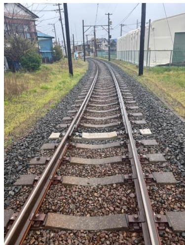
新橋踏切～興人南踏切間 275m
